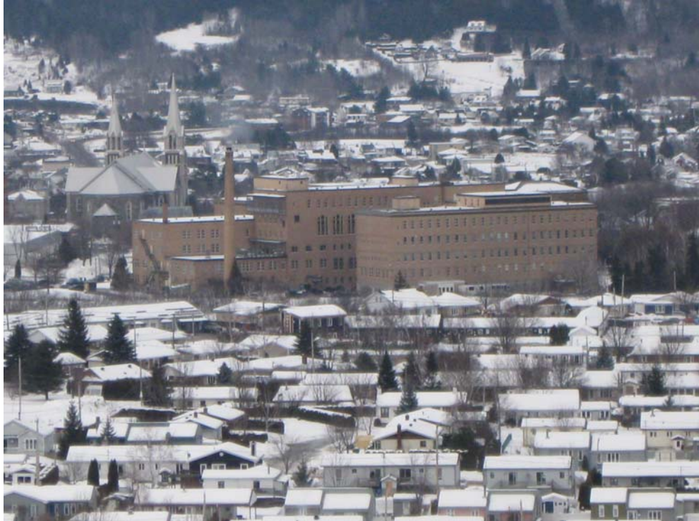
Figure 2 – Hôpital de Baie-Saint-Paul
